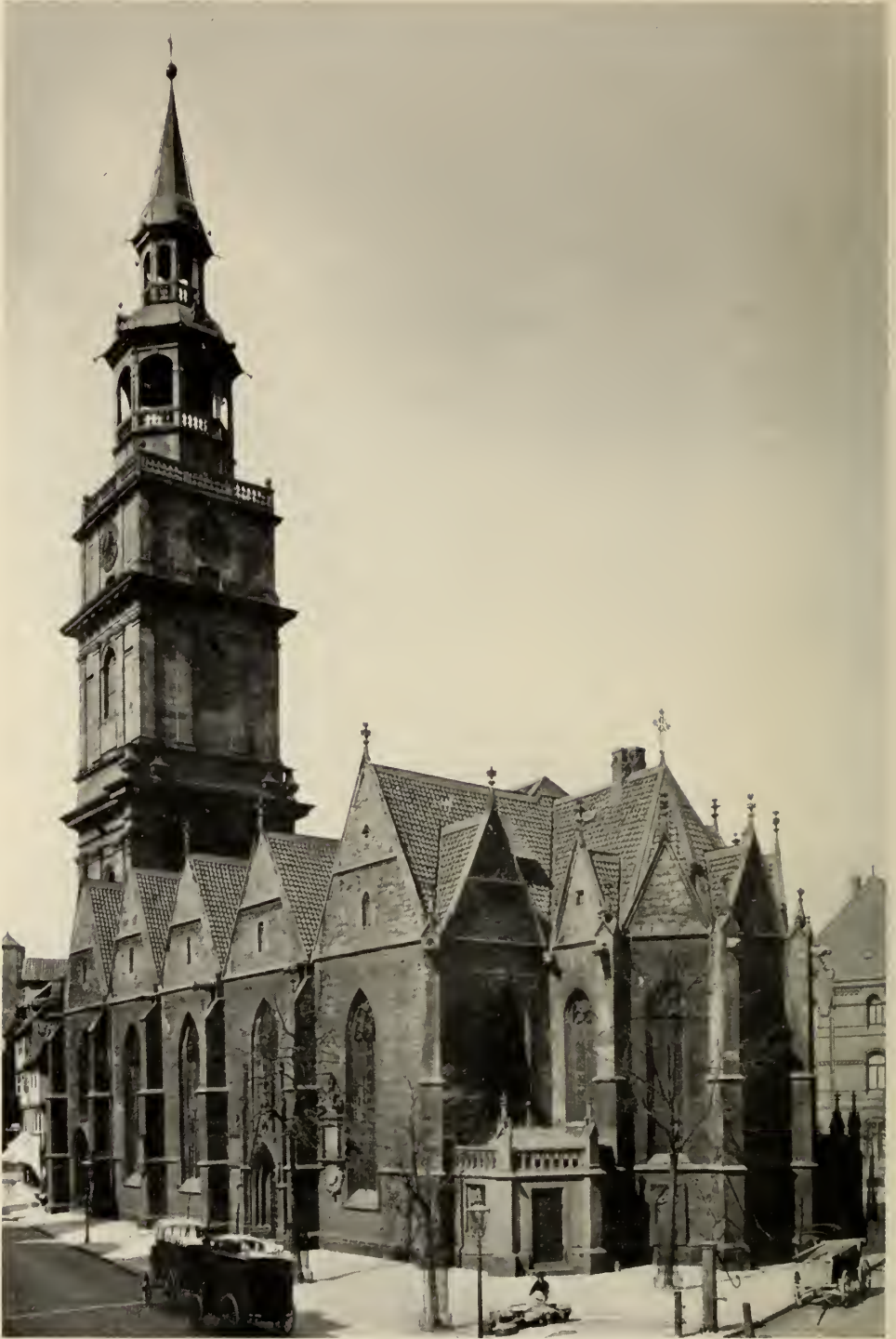
Abb. 64. Hannover; Ägidienkirche, Gesamtansicht von Südosten. Phot. 1900.
