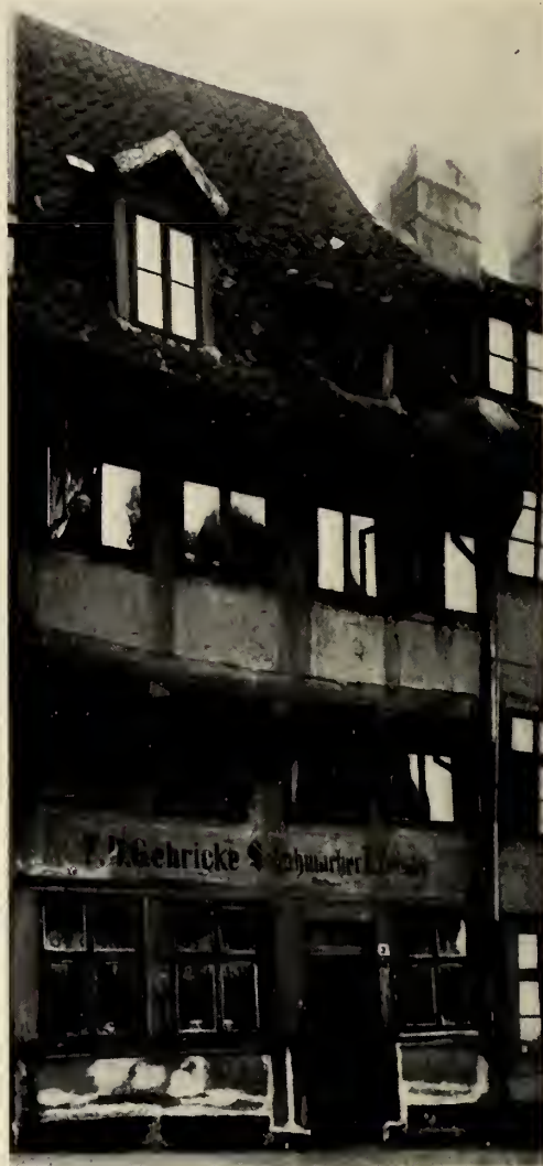
Abb. 410. Hannover; Mühlenstraße 3. Setzschwelle des 2. O.-G. mit Leistentrapezen. Phot. 1905.
