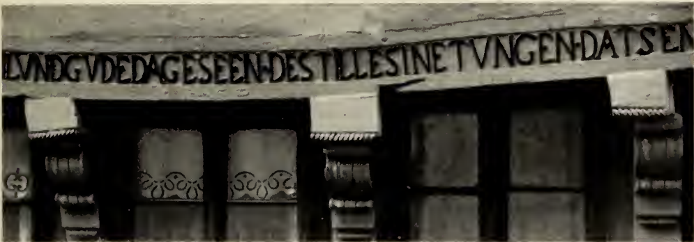
Abb. 297. Hannover; Ballhofstraße 2. S-Konsolen und Setzschwelle des 1. Obergeschosses mit Inschrift. Phot. 1904.
