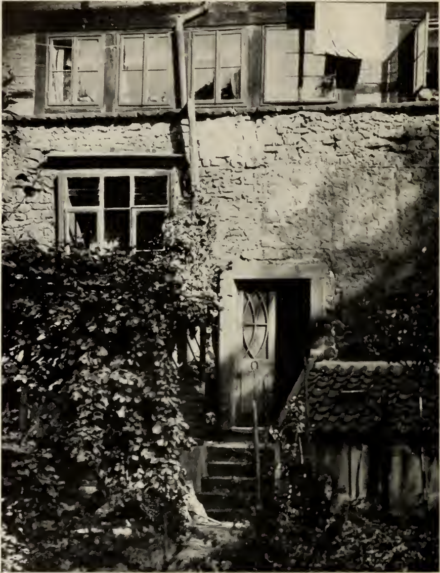
Abb. 8. Hannover; Stadtmauer auf dem Grundstück Friedrichstraße 17. Phot. 1905.
