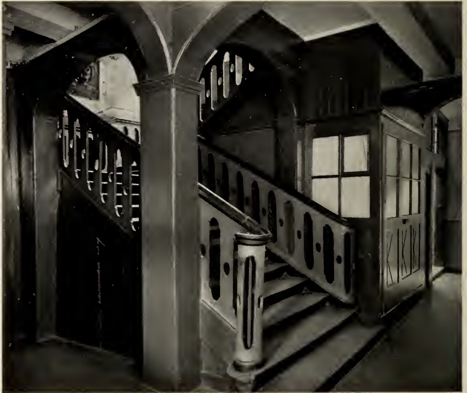
Abb. 460. Hannover; Neue Straße 21, Hotel Stadt London, nachmals Duvesches Armenhaus, Treppenhaus. Phot. M. B. A., 1928.
