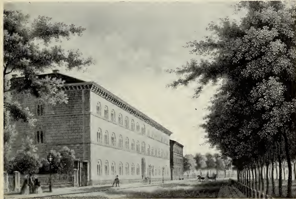
Abb. 493. Hannover; das Polytechnikum an der Georgstraße von Ebeling und das Gebäude der Militär-Bekleidungskommission von Tramm. Nach Kretschmer.
