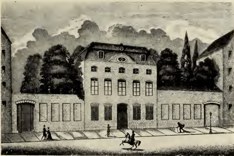
Abb. 285. Hannover; Köbelingerstraße 7a. Haus des Kammerherrn v. Wallmoden, abgebrochen 1887. Nach Holzschnitt im Stadtarchiv.
