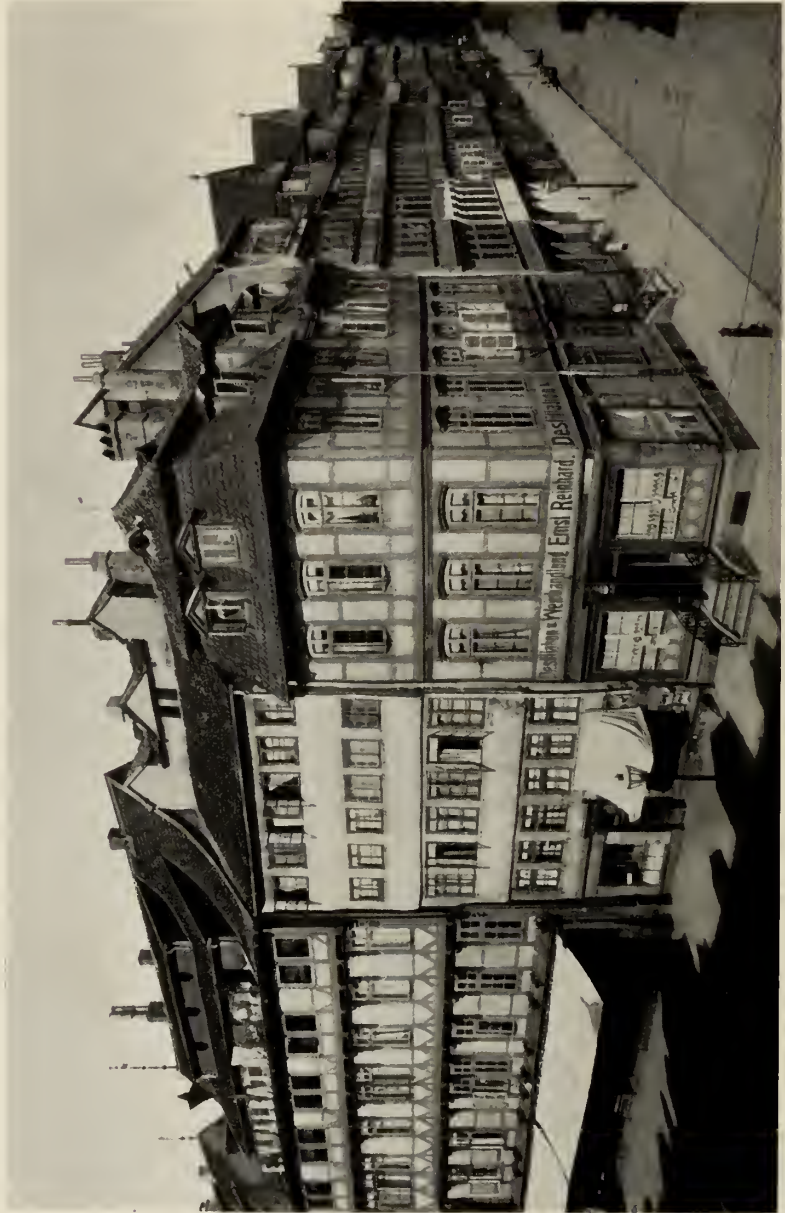
Abb. 322. Hannover; Calenberger Straße 34—36 und Blick auf die Duxenhäuser in der Roten Reihe. Phot. 1905.
