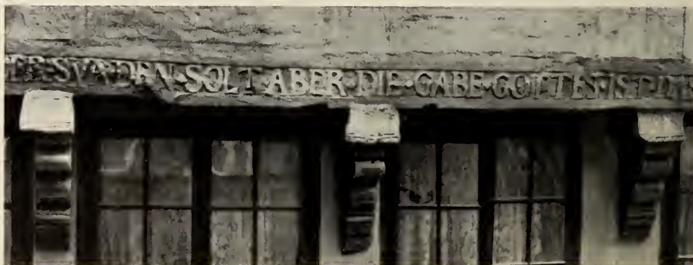
Abb. 298. Hannover; Ballhofstraße 10, Trommelkonsolen und Setzschwelle des 1. Obergeschosses mit Inschrift.
